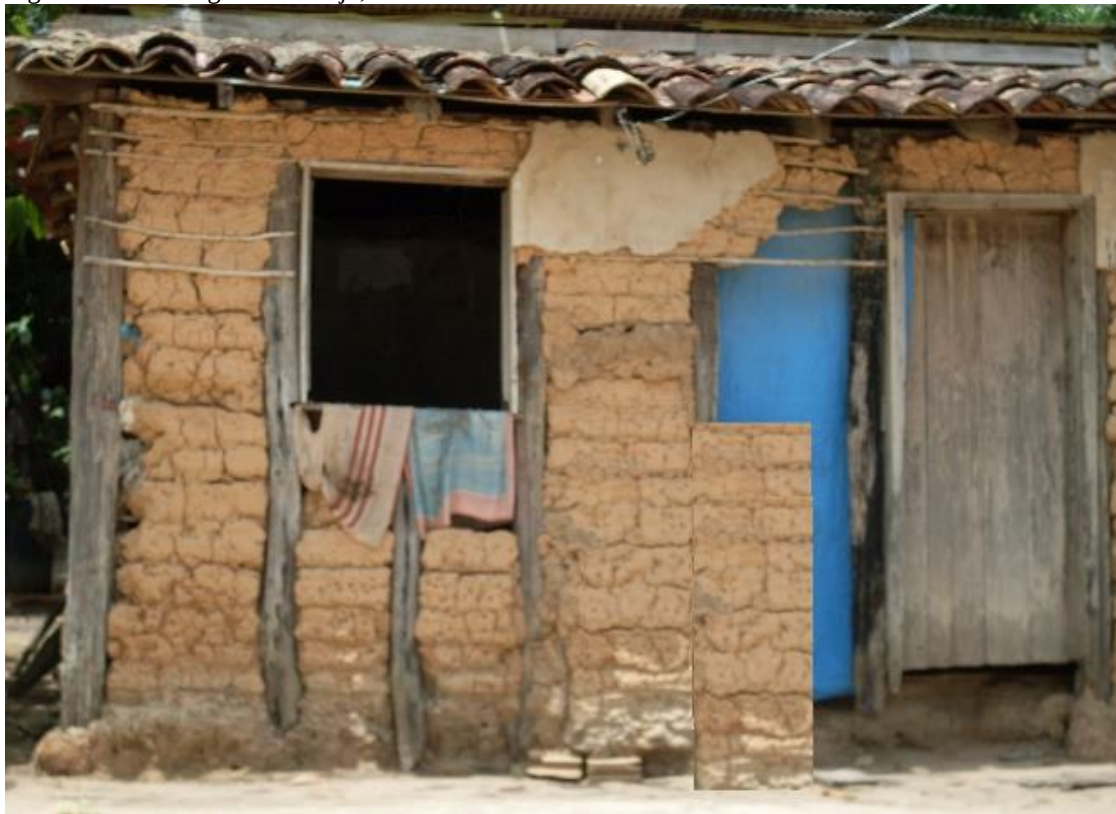
Figura 5: Casa antiga do Vilarajo, construída de barro.
