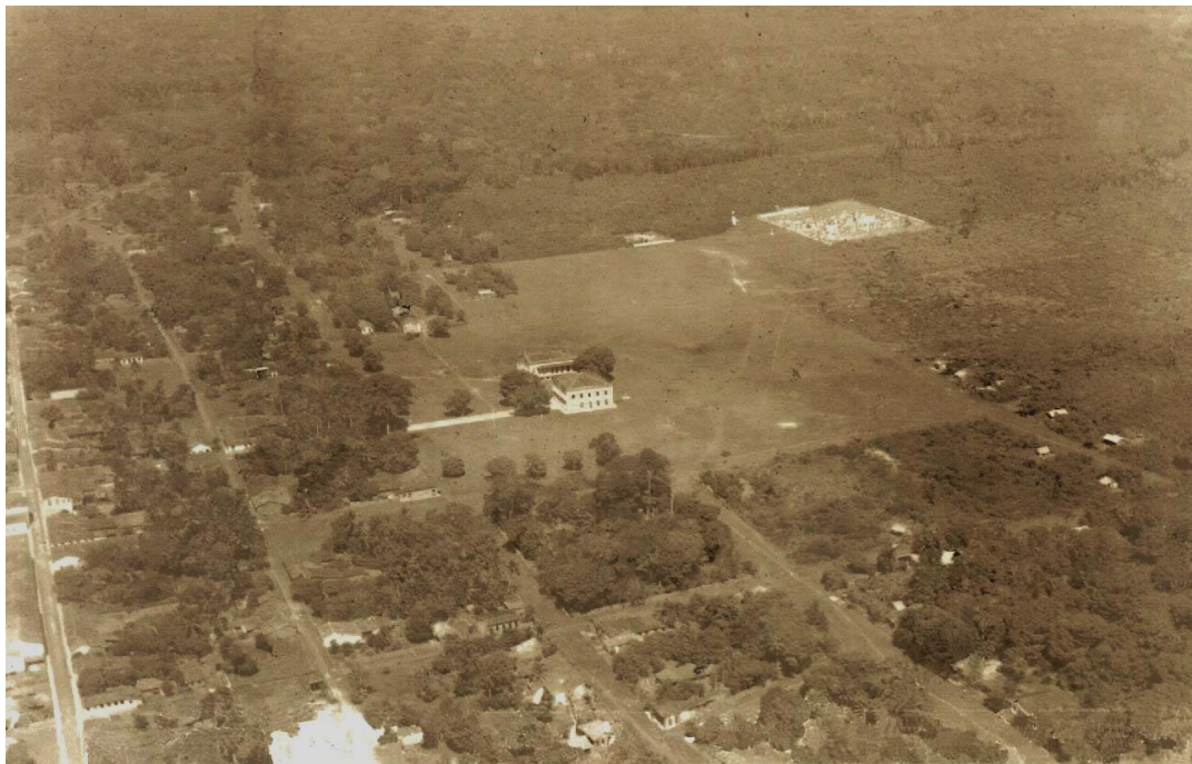
Imagem 02: Vista aérea da Cidade de Cametá. Década de 1950 (sem data específica)
